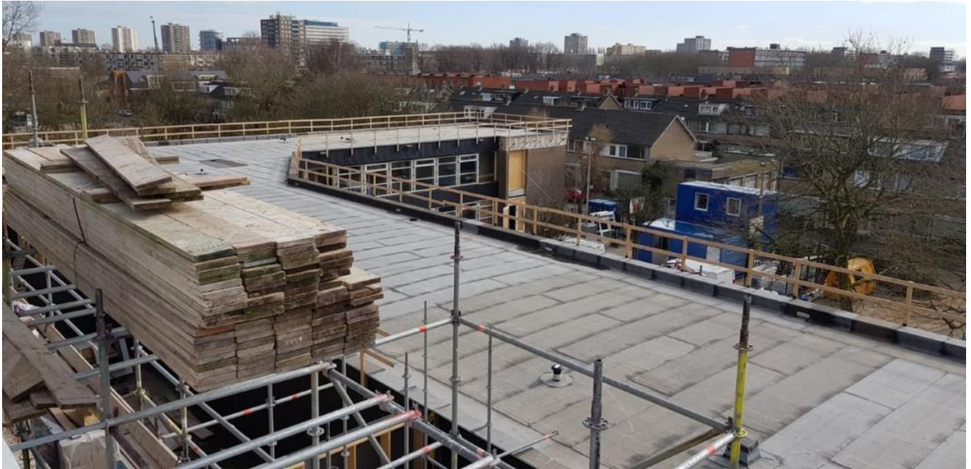
Dak nieuwbouw Rudolf Steinerschool
